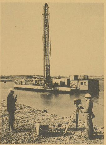
Environ 6000 drains à mèche gainés du géotextile « Typar » en polypropylène ont été installés sous l'eau par Cementation Ground Engineering au moyen de ce dispositif à mandrin monté sur le ponton. L'emploi du « Mebra-Drain » diminue la période de consolidation avant de commencer la construction d'un talus pour faire passer de manière économique un pont au-dessus de ce bassin de radoub.
