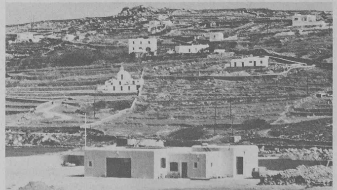
Ce bâtiment a été conçu pour s'intégrer dans l'architecture locale de l'île grecque de Mykonos. Il abrite la première installation importante de dessalement de l'eau de mer par osmose inverse qui ait été montée en Grèce et qui produit quotidiennement 500 000 litres d'eau douce.
