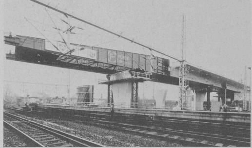
Pour les ouvrages en béton précontraint dont les aciers de précontrainte sont logés dans des tubes de gainage, on utilise en République fédérale d'Allemagne presque exclusivement les adjuvants pour mortier d'injection Tricosal® 181 et 183. C'est aussi le cas pour la construction du pont sur la gare de Hambourg-Harbourg (notre photographie).
