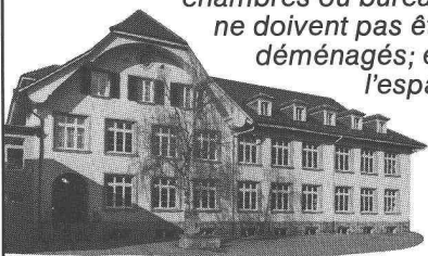
Ecole à Bremgarten, BE. Rénovation avec fenêtres à cadre rapporté bois et vitrage isolant.
