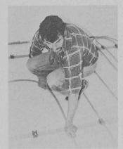
Montage précis et sûr du chauffage par le sol Unitex par la mé-thode d'étirage rapide.
