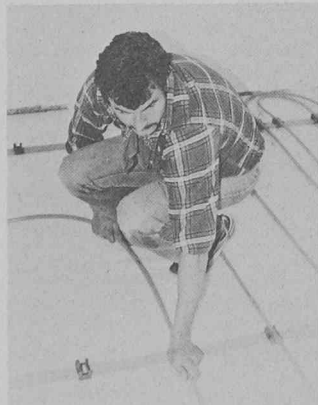
Montage précis et sûr du chauffage par le sol Unitex par la méthode d'étirage rapide.
