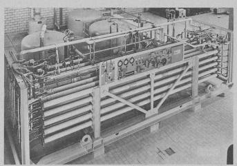
Installation d'osmose inverse de la Swissair (aéroport de Zurich-Kloten), d'une capacité de 730 m³/jour.
