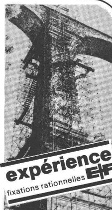
Fixation d'un coffrage
