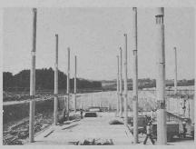
Colonnes avec tête de poinçonnement en acier.
