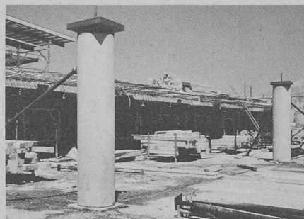
Colonnes sur plusieurs niveaux, Collège secondaire, Echallens.
