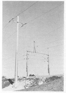
Fig. 10. — Mât porteur d'angle en pleine voie
