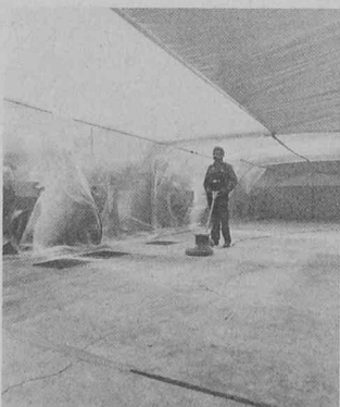
Assainissement d'un sol industriel, notamment avec colmatage des fissures, des trous et des failles.
