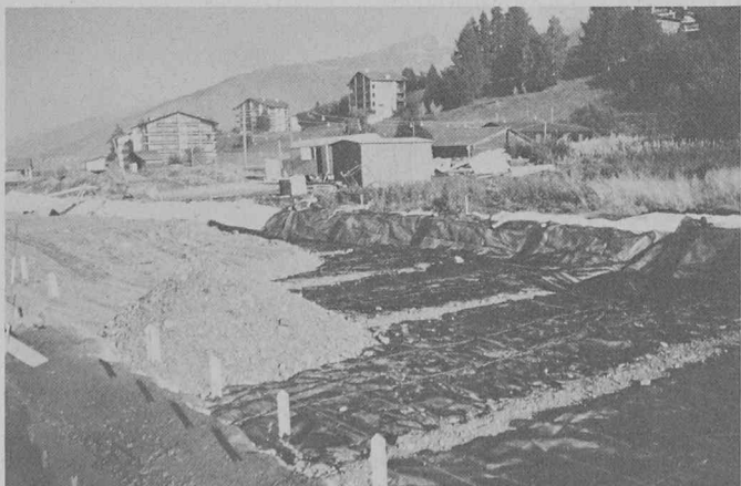
Géotextiles dans les constructions routières.
