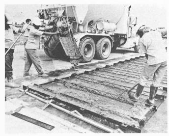
Fig. 6. — Panneau en cours de bétonnage.
