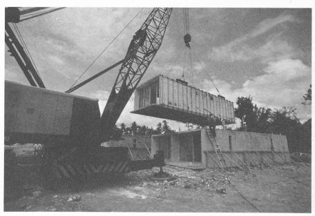
Fig. 1. — Mise en place des modules.
