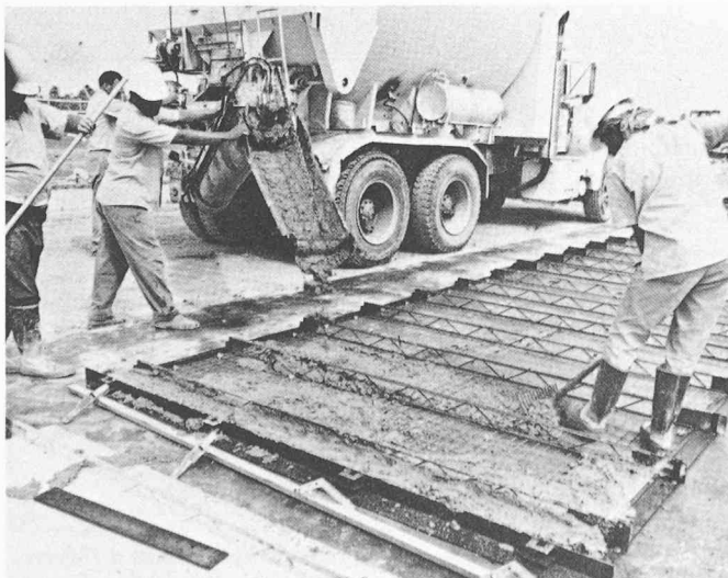
Fig. 6. — Panneau en cours de bétonnage.
