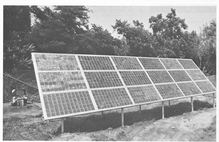
Fig. 6. — Panneau de cellules photovoltaïques.
