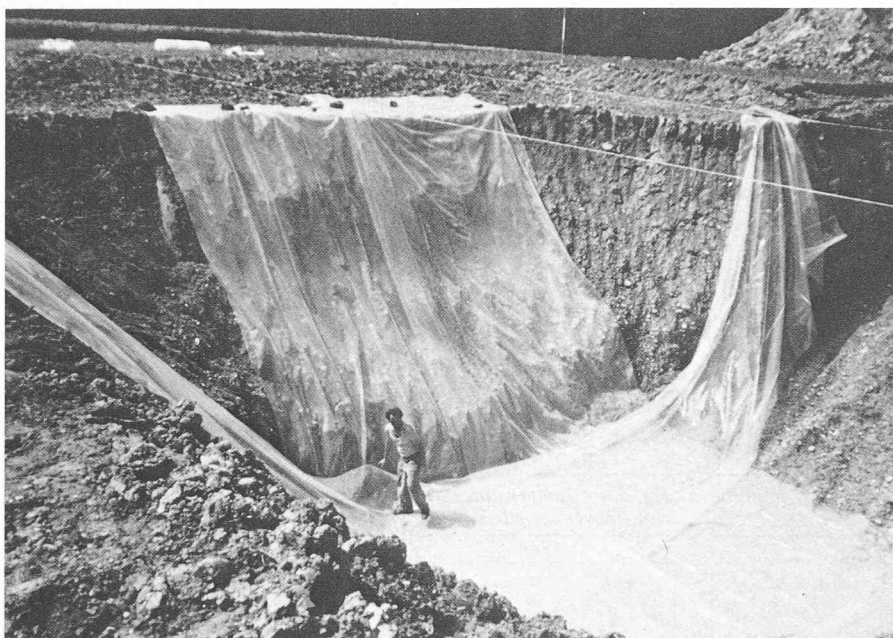
Fig. 2. — Vue générale du stock excavé. Pose des feuilles polyéthylène.
