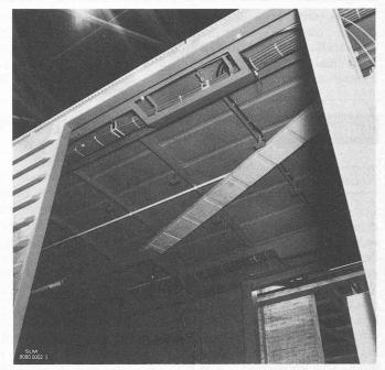
Fig. 7. — Vue partielle du toit avec câbles et conduites d'air comprimé en cours d'installation.
