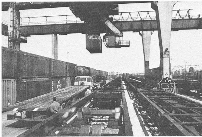
Fig. 8. — Pont roulant de 40 t sur 10 voies de circulation au terminal intermodal de Milan-Rogoredo.
