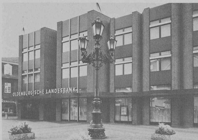
Vue extérieure de la banque où presque 90% des besoins en chauffage sont couverts par une pompe à chaleur.
