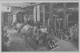
Groupe d'acide nitrique Escher Wyss, installé dans l'entreprise Superfos à Fredericia (Danemark), avec turbine à vapeur, compresseurs axial et radial, turbine de détente, engrenage et génératrice.
