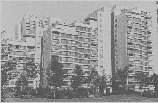
Immeubles locatifs de Murifeld, à Berne, comprenant au total 268 bouches d'aération automatique posées ultérieurement.
