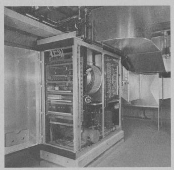
Installation de pompes à chaleur Solset d'une capacité calorifique de 20 kW. Source de chaleur: air usé des locaux sanitaires.
