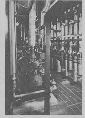
Salle des machines de l'installation de pompe à chaleur avec moteur à gaz (au premier plan) et système de distribution de chaleur (à droite).
