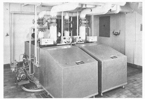
La nouvelle centrale de chauffage du bâtiment des PTT: 2 chaudières de 290 kW à brûleurs modulants bi-combustible gaz/mazout. Economies d'énergie grâce à la rénovation: 37%.
