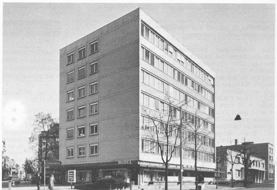
Economie d'énergie grâce au chauffage au gaz : bâtiment PTT à la place Victoria à Berne.
