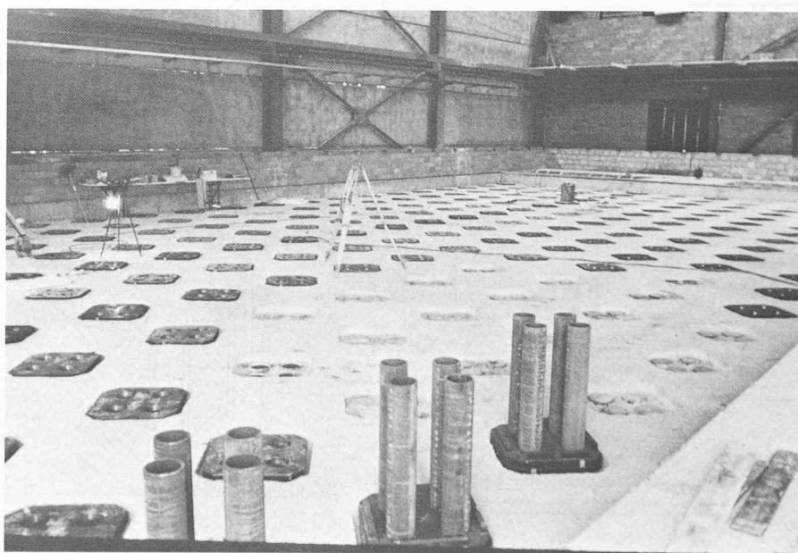
Fig. 7. — Construction de la dalle supérieure du banc d'essais principal. Cette photo a été prise pendant la mise en place des plaques supérieures des ancrages munies des tubes. On remarque au premier plan 3 plaques en attente, avant retournement dans les gaines noyées dans le béton. A l'arrière-plan, on distingue les instruments de précision pour le réglage et le contrôle géométrique des ancrages.
