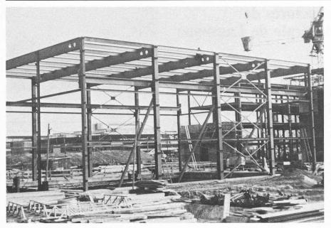
Fig. 3. — Charpente métallique en montage.
