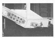
Fig. 13. — Réparation des ouvrages fissurés par fatigue. Cette photo montre, pour le même nœud du treillis, deux réparations effectuées. A droite, l'arrêt de la propagation de la fissure par perçage d'un trou à la pointe de la fissure; à gauche, réparation complète par joint boulonné.
