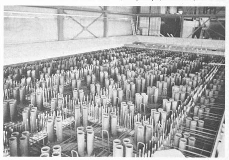
Fig. 6. — Construction de la dalle supérieure du banc d'essais principal. Cette photo a été prise avant le bétonnage de la partie inférieure de da dalle. On y voit les groupes de 4 gaines, destinées à recevoir les tubes d'ancrages, ainsi que la nappe inférieure de l'armature. On remarque également le muret de nivellement et d'implantation des ancrages, construit autour du banc d'essais, et qui a été démoli par la suite.
