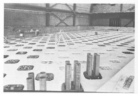
Fig. 7. — Construction de la dalle supérieure du banc d'essais principal. Cette photo a été prise pendant la mise en place des plaques supérieures des ancrages munies des tubes. On remarque au premier plan 3 plaques en attente, avant retournement dans les gaines noyées dans le béton. A l'arrière-plan, on distingue les instruments de précision pour le réglage et le contrôle géométrique des ancrages.
