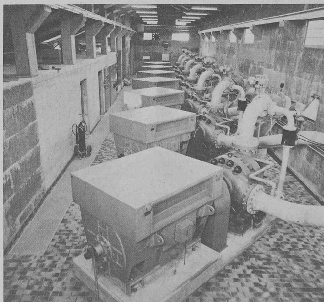
Installation de Tannuwald (Suisse) comprenant 7 pompes normalisées mises en parallèle, développant une puissance totale de 6,5 MW.
