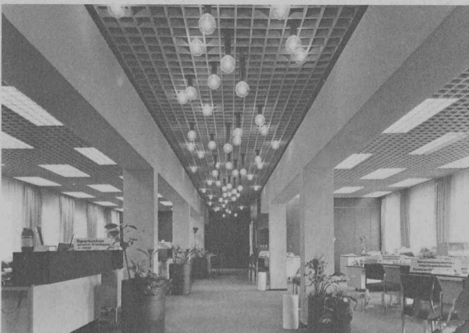
Ces photos de plafonds alvéolaires Pagolux visualisent la collaboration entre éclairagistes, acousticiens et techniciens en climatisation qui ont réussi à intégrer «leur» technique à un plafond décoratif, sans que cette technique ne soit trop apparente.
