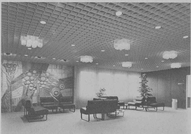
Ces photos de plafonds alvéolaires Pagolux visualisent la collaboration entre éclairagistes, acousticiens et techniciens en climatisation qui ont réussi à intégrer «leur» technique à un plafond décoratif, sans que cette technique ne soit trop apparente.
