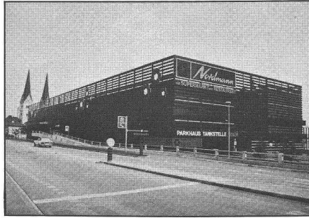
Parking à étages avec accès par rampes
