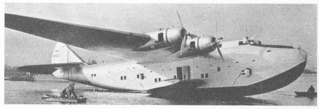
Fig. 5. — Un des demiers hydravions de transport, le Boeing 314 Clipper, a assuré en 1939 les premiers services sur l'Atlantic Nord. Exact contemporain du DC-4, ce bel avion de 38 tonnes au décollage, emportant 74 passagers à 300 km/h sur près de 6 000 km, n'aura connu qu'une fort brève carrière.
