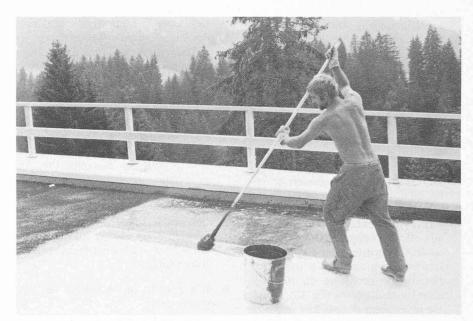
Fig. 11. — Pose manuelle de l'étanchéité néoprène (Efkaprène®).
