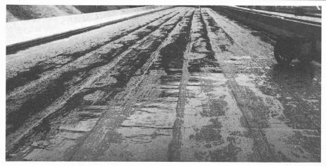
Fig. 8. — Les joints entre des feuilles à base de bitume modifié forment une retenue d'eau qui reste dans les pores de l'enrobé.
