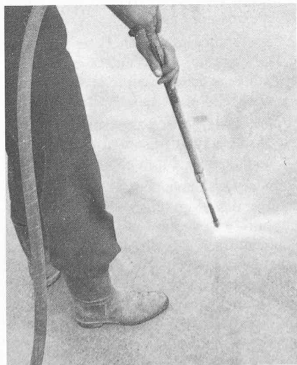
Fig. 9. — Nettoyage à l'eau sous très haute pression de la surface du béton (750 bars).
