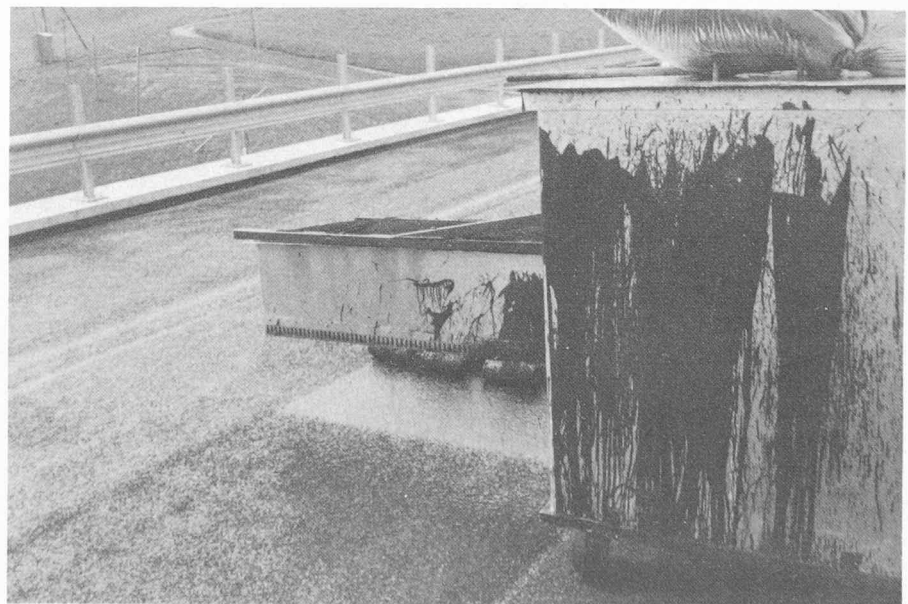
Fig. 15. — Epanchage à la machine des granules de caoutchouc servant de liaison avec le revêtement.
