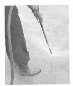
Fig. 9. — Nettoyage à l'eau sous très haute pression de la surface du béton (750 bars).
