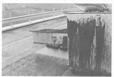
Fig. 15. — Epandage à la machine des granulés de caoutchouc servant de liaison avec le revêtement.
