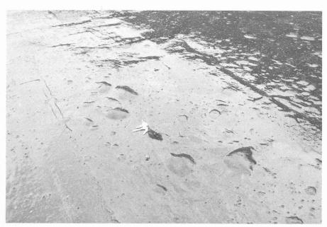
Fig. 3. — Bulles apparues sous une feuille préfabriquée à base de bitume modifié.
