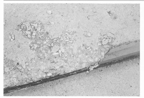
Fig. 4. — Béton désagrégé par le choc de température provenant du sel de déneigement. On remarque très bien la différence entre le béton de la surface et celui du noyau. Une protection ne peut pas empêcher cette désagrégation.
