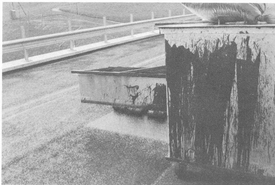
Fig. 15. — Epandage à la machine des granules de caoutchouc servant de liaison avec le revêtement.
