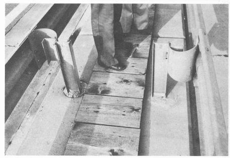
Fig. 17. — Les glissières de sécurité se trouvent au-dessus des bordures. Détail du poteau de droite: mise en service du pont en 1971. La protection du scellement du poteau fut posée en 1975, ce qui signifie qu'elle a été exposée au sel de déneigement durant 4 ans sans protection et durant 5 ans avec une protection. Exemple pris sur la N5 (photo 1980, protection Efkaprène).
