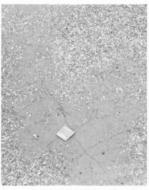
Fig. 6. — Ce revêtement d'asphalte coulé s'est désagrégé après un hiver seulement, l'étanchéité étant épaisse et trop tendre.
