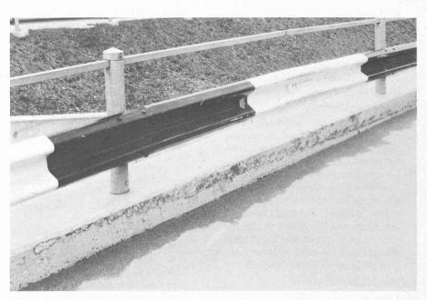
Fig. 1. — Protection de bordures endommagée par le chasse-neige.
