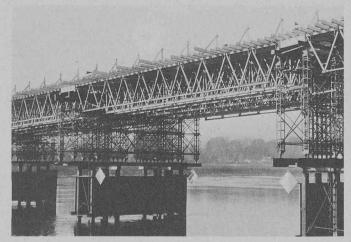
Construction de pont grâce à l'utilisation combinée de poutres Innocenti et d'échafaudages M 180, permettant d'atteindre des portées de 36 m.
