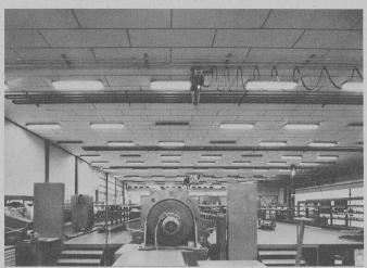
1200 m² Schichtex-Spécial 50/III avec rainures longitudinales et battues à la largeur, en longeurs différentes, côté visible avec feuille blanche en PVC, posé en pro-fils double-T et suspendu sous dalles.
