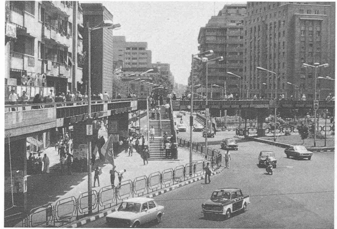
Vues de la place El Tahrir au centre du Caire, Egypte. Un giratoire piétonnier complet érigé en estacade assure les liaisons entre les quartiers adjacents.
