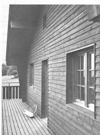
Fig. 2. — Exemple de bardage de façade en bois.
