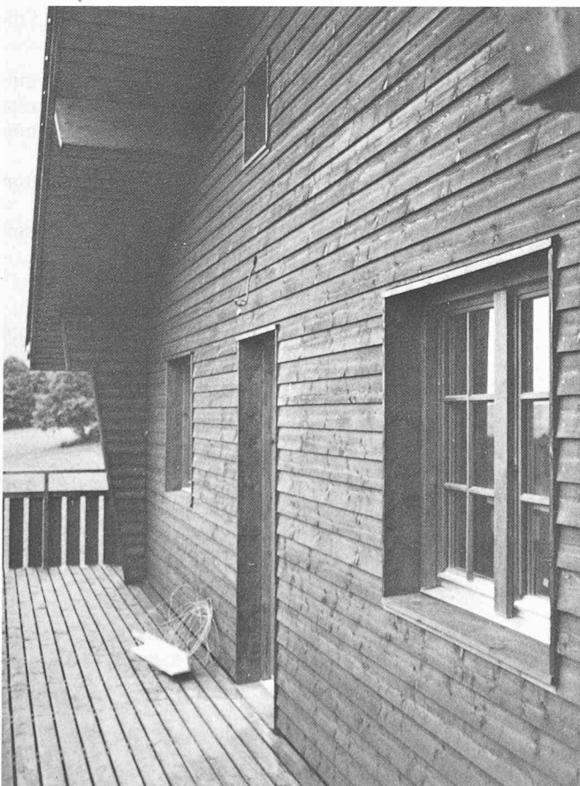
Fig. 2. — Exemple de bardage de façade en bois.
