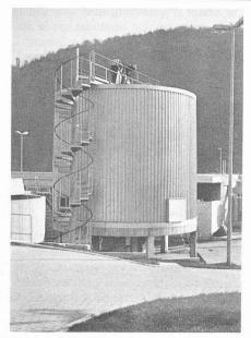
Fig. 8. — Tour de compostage de boues d'épuration (B.A.V.).
