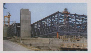
Un réseau de pannes, espacées de 3,60 m<sup>1</sup>, supporte la couverture et s'appuie sur des poutres triangulées secondaires, espacées de 7,20 m<sup>1</sup> (module) et longues de 21,60 m<sup>1</sup>.
