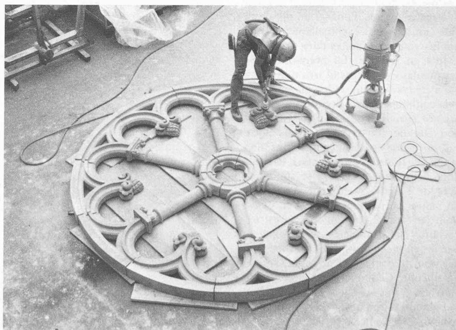
Fig. 7. — Sablage de la rose assemblée au sol.
