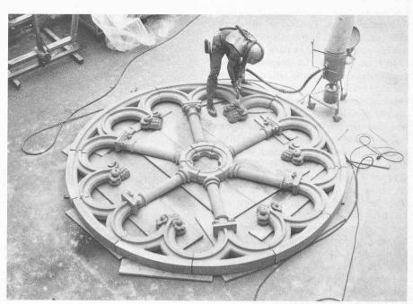
Fig. 7. — Sablage de la rose assemblée au sol.
