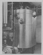
Echangeur de chaleur boues-boues de Sulzer pour une utilisation optimale de l'énergie dans la prépasteurisation des boues d'épuration.
