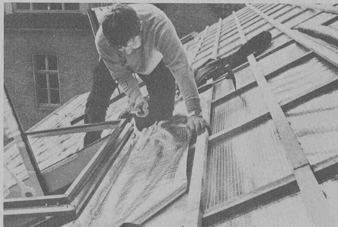
Les feuilles isolantes «Mylar» métallisées sont faciles à poser et assurent, de jour et de nuit, une température agréable dans les mansardes, même en été; elles agissent également comme protection contre la pluie, la neige et la poussière.
