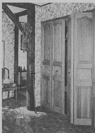
Quercy: fabrication en chêne, montants et traverses à moulures petit cadre et panneaux à plate-bande. La traverse supérieure est en forme de chapeau de gendarme.
