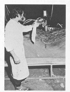
La projection, à l'aide d'un appareit spécial, d'un mélange de résine polyester et de fibre de verre, permettra d'obtenir, après polymérisation, une couche résistante et incombustible d'environ 5 mm d'épaisseur.
