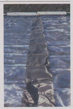
Fig. 14. — Recouvrement des laizes (tissé).
