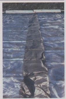
Fig. 14. — Recouvrement des laizes (tissé).
