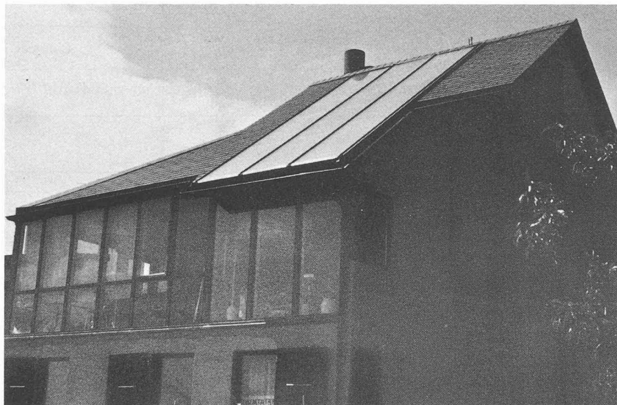
Fig. 1 — Façades est et sud.
