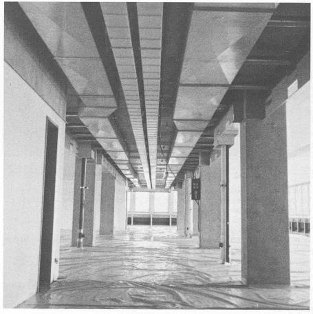
Fig. 21. — Canaux de distribution électrique et de ventilation dans faux plafonds des corridors.
