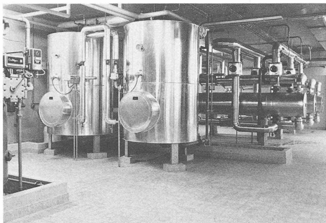
Fig. 23. — Echangeurs de chaleur avec production d'eau chaude sanitaire.
