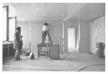
Fig. 10. — Montage des cloisons mobiles
