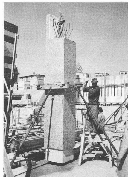
Fig. 16. — Pilier articulé au rez-de-chaussée.
