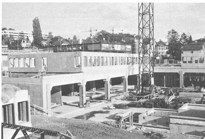
Fig. 8. et 9. — Pose des façades en éléments préfabriqués.
