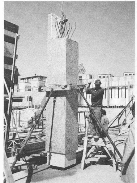
Fig. 16. — Pilier articulé au rez-de-chaussée.
