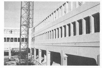
Fig. 8. et 9. — Pose des façades en éléments préfabriqués.
