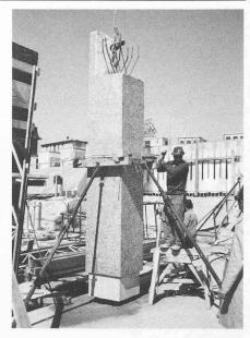
Fig. 16. — Pilier articulé au rez-de-chaussée.
