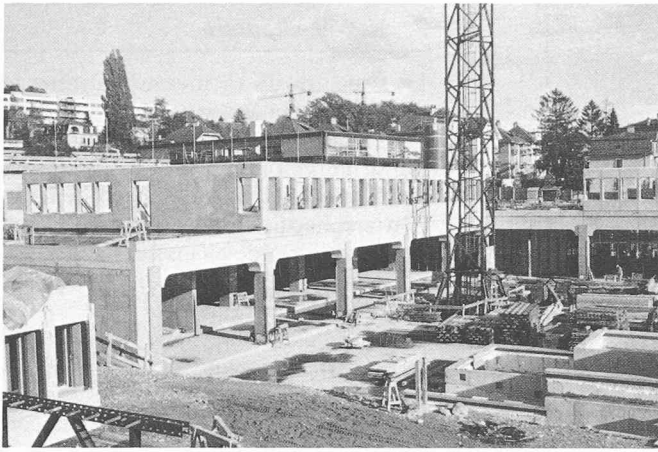
Fig. 8. et 9. — Pose des façades en éléments préfabriqués.
