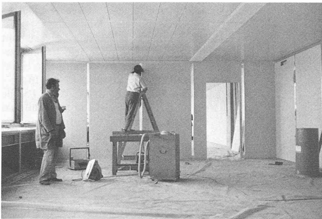
Fig. 10. — Montage des cloisons mobiles.
