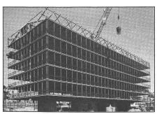
Ossature de bâtiment administratif à étage suspendue aux poutres de toiture
