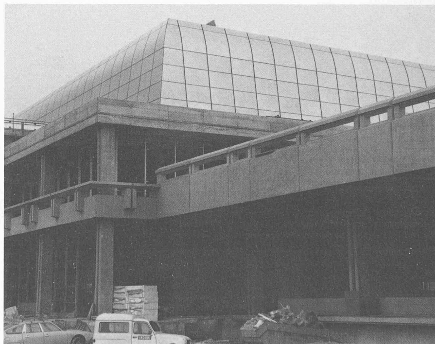
Fig. 3 — Façade est: gare postale et bâtiment d'exploitation.
