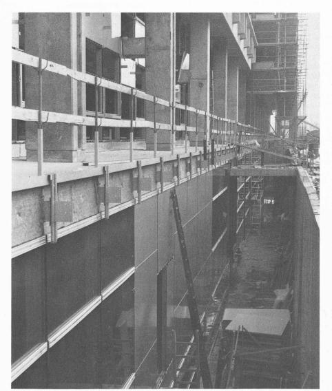
Fig. 8 — Vue en enfilade de la façade est du bâtiment d'exploitation. Détail du puits de lumière servant à l'éclairement naturel de l'étage inférieur.
