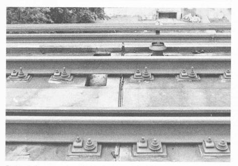
Fig. 4. — Rails continus au-dessus d'un joint du tablier au viaduc de Westmont.
