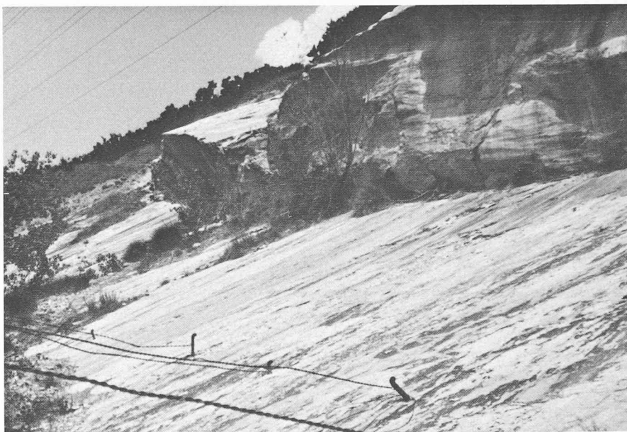
Fig. 11. — Vue de la falaise en mouvement et du plan de glissement, avant le début des travaux d'assainissement.
