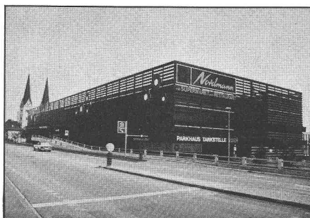
Parking à étages avec accès par rampes
