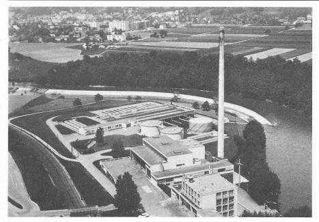
Fig. 4. — Centrale électrique à ordures, station d'épuration des eaux usées et installation d'élimination de déchets liquides spéciaux de la région Baden/Brougg. Capacité: 2 × 100 t/24 h ordures, 2 × 12,5 t/h vapeur.
