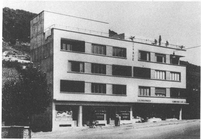
Fig. 14. — Immeuble «Zur Aue».
