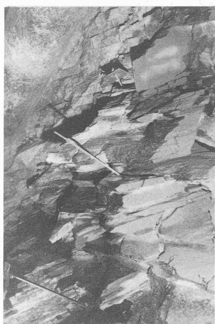
Fig. 3. — Lot d'Oberwald, km 3,775: flambage dans le stross d'une zone de schistes de homblende à fine schistosité.
