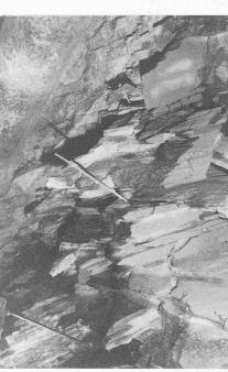
Fig. 3. — Lot d'Oberwald, km 3,775: flambage dans le stross d'une zone de schistes de homblende à fine schistosité.
