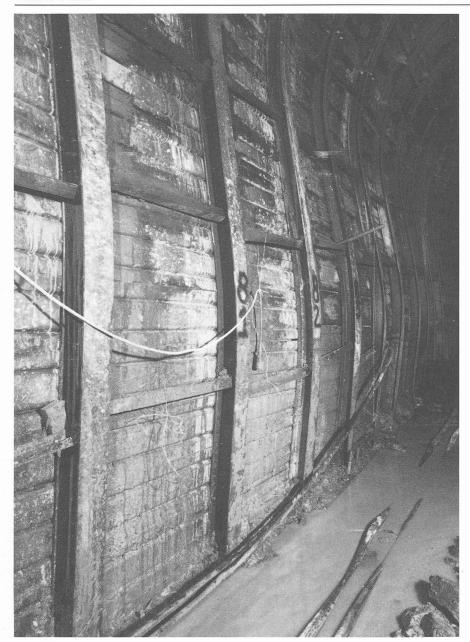
Fig. 7. — Effets de la poussée des terrains sur les soutènements en acier. Les déformations atteignirent par endroits 40 à 50 cm.
