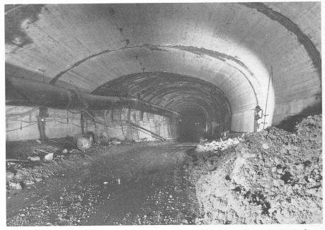
Fig. 8. — Tunnel de contournement d'Oberwald. Transition entre la voie unique et la voie double (60 m²), réalisé par un avancement en calotte.
