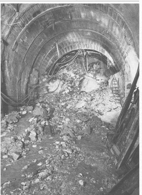
Fig. 6. — km 3,380: entrées d'eau, de boue et de roches dans la zone du granite de Rotondo (29 juin 1977). L'avancement en a été retardé de six mois.
