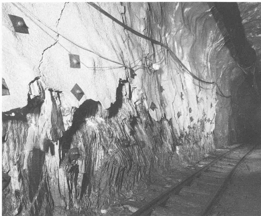
Fig. 4. — km 1,570: état le 23 février 1978, trois ans après l'excavation. On voit la gunité de sécurité nécessaire à l'avancement, les ancrages, le flambage et l'écaillage des paragneiss à fines couches. Couverture: env. 500 m.
