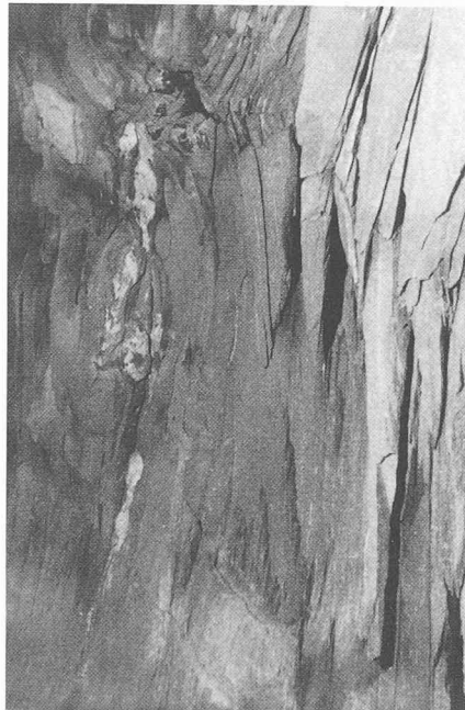
Fig. 3. — Lot d'Oberwald, km 3,775: flambage dans le stross d'une zone de schistes de homblende à fine schistosité. Couverture: env. 1200 m. Les photos ont été prises cinq jours après excavation.
