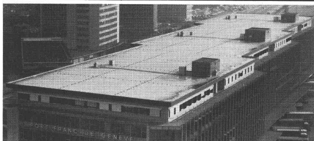
B488 Port-franc, Genève – Architecte: Koechlin René et Mozer Marc, Genève 7'000 m² fixés mécaniquement
