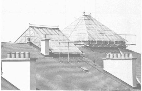
Fig. 6. — Détail de la toiture de l'immeuble Charles Bonnet — les verrières sont des terminaisons fonctionnelles pour toutes les gaines verticales (escaliers et petites cours d'éclairement des locaux secondaires). (Photo Yvan Maurice)
